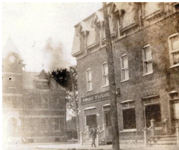
Banque d'Hochelaga, rue du Pont
